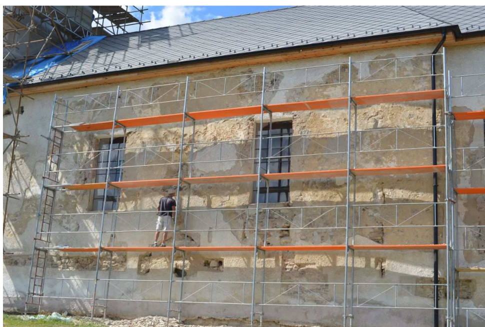
Pohľad na južné fasádu lode kostola v procese odstraňovania sekundárnych pomietok
