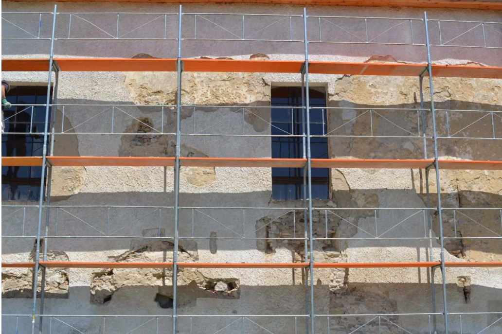
Južná fasáda počas čistenia a odstraňovania cementových omietok
