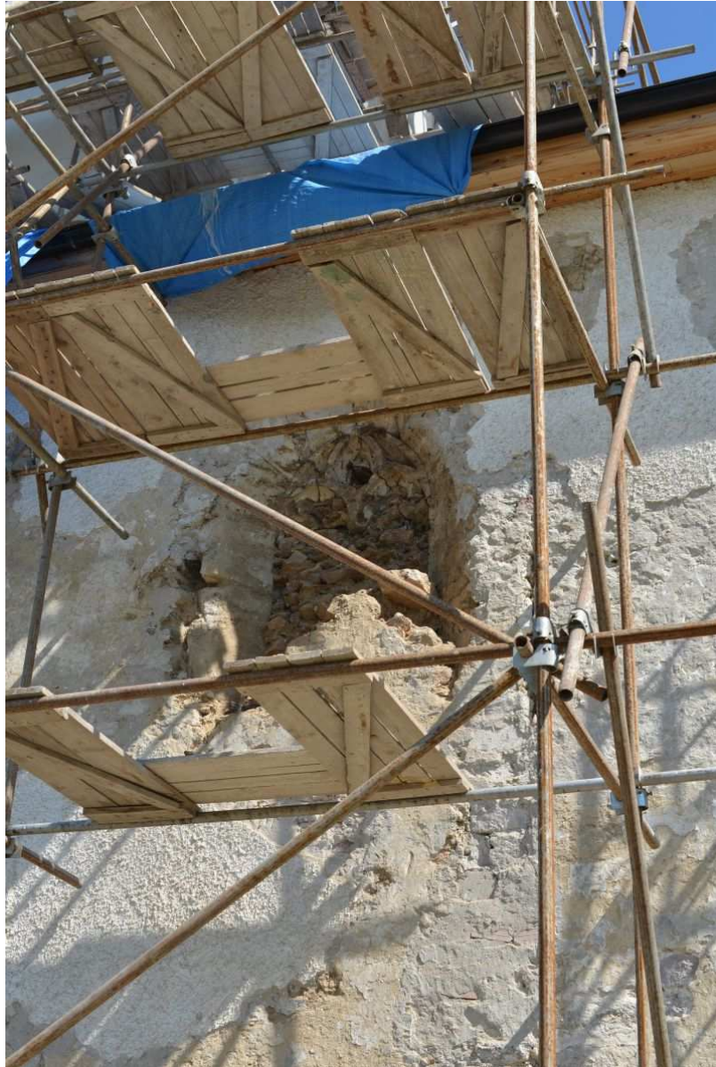
Odstraňovanie zámurovky z gotického okna
