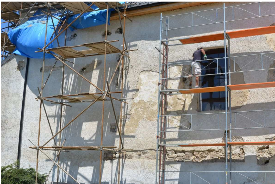
Južná fasáda počas čistenia a odstraňovania cementových omietok
